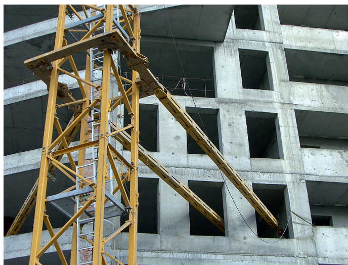
Крепление башенных кранов к перекрытиям и колоннам в высотном строительстве
