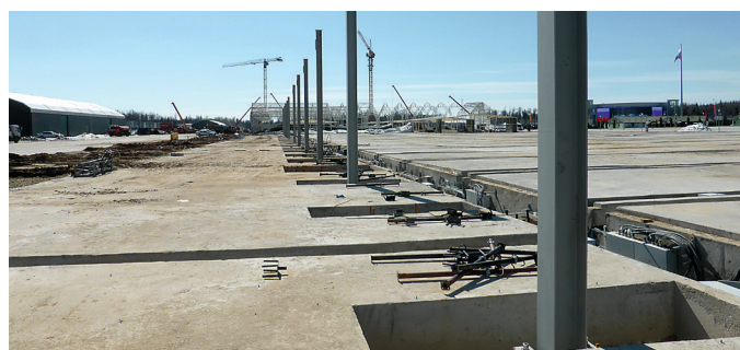
Монтаж колонн здания учебно-демонстрационного центра. Протяженность по фасаду 1560 метров (Военно-патриотический парк культуры и отдыха Вооруженных сил РФ «Патриот», Московская область, г. Кубинка, 2016 г.)
