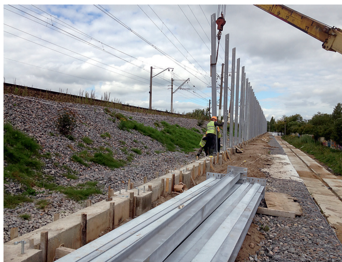
Монтаж металлических стоек шумозащитных экранов к железобетонному ростверку вдоль железнодорожных путей (г. Павловск, 2013 г.)
