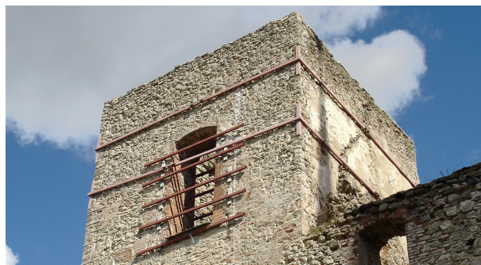
Крепление элементов металлической обвязки к кладке стен из природного камня при усилении памятника архитектуры 16 века
